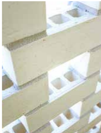
光を取り込む透かし積みレンガ
